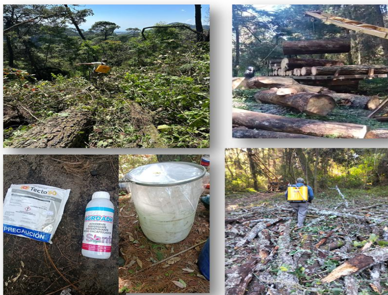
Figura 17. Actividades de derribo, troceo y aplicación de químico
